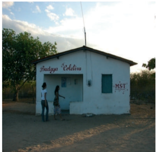
Foto 1 – da Bodega Coletiva do Assentamento
