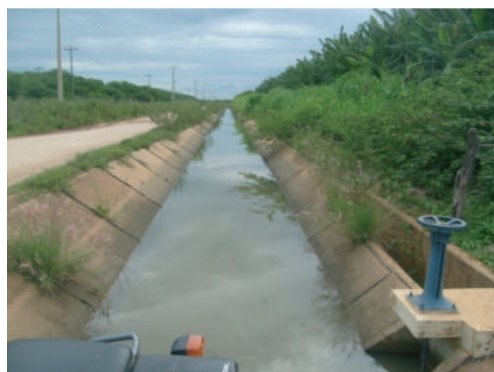
Foto 10 – Canal a Céu Aberto
