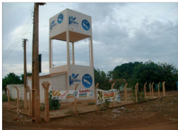
Foto 3 – Sistema de abastecimento do SAAE (Tomé – Limoeiro do Norte)
